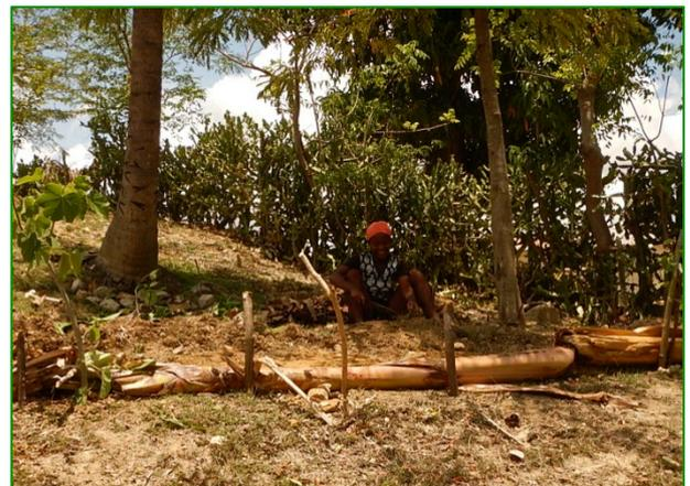
Figure 11: Construction d'une mini terrasse
