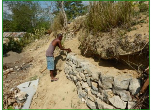
Figure 10: Construction d'un mur de soutènement
