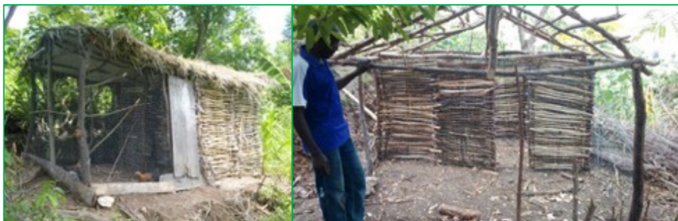
A g. le poulailler de Lumenes ; à d. celui de Verdieu (en construction)
